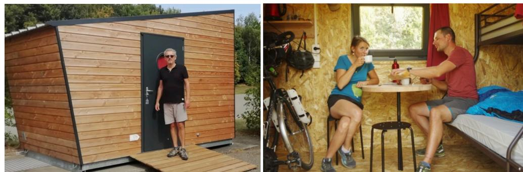
Hello Cabanes \_Les cabanes d'étapes d'Yves Poullain: 8 m2, conçues en bois recyclé et en France, sans fondations mais avec un système de serrure à code, qui leur permet d'être implantées aussi bien dans des campings que sur des terrains communaux.
